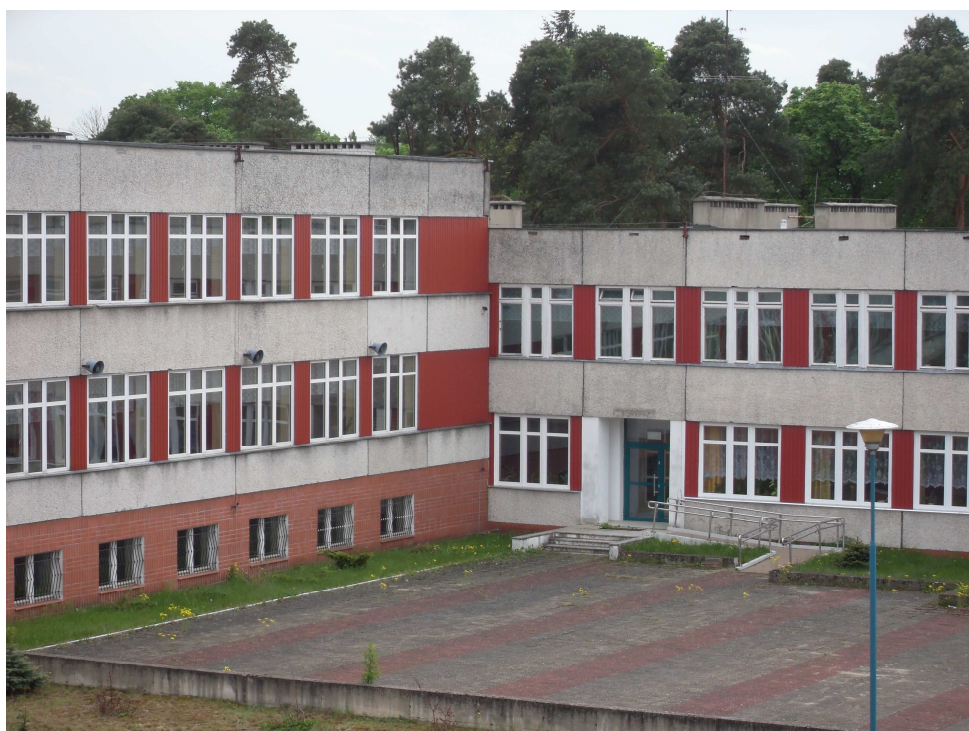
Elewacja tylna budynku C (okna C1) i elewacja tylna budynku B (okna B4) – widoczne są także nowe okna PVC na korytarzu budynku B i w salach szkoły muzycznej w budynku C
